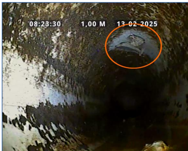
Photo 13 – Segment endommagée à 1,0 m en amont de R2
